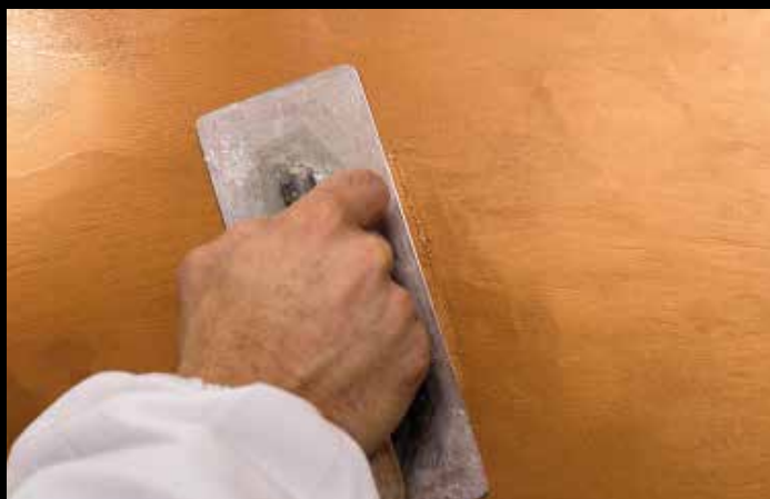
Faza 3 Nakon 3-5 min suvom gletericom preći preko dekorativne boje radi postizanja efekta pliša
