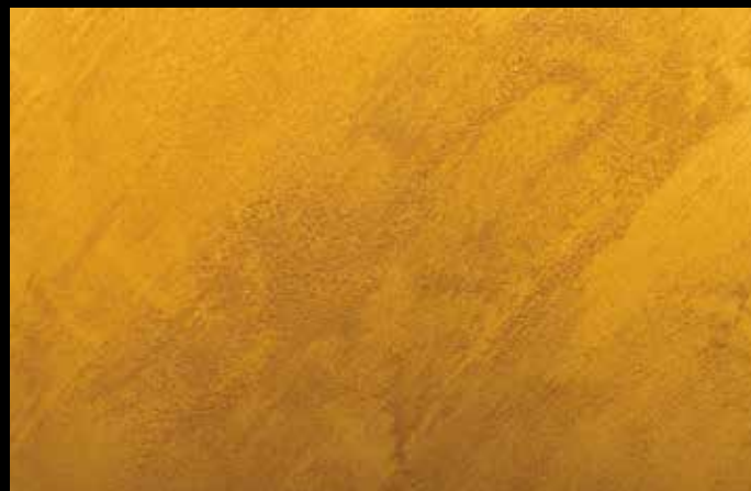
Faza 4 Završni izgled zida
