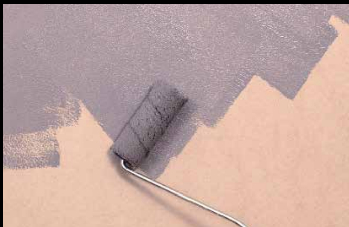
Faza 1 Nanošenje podložne boje po TCC ton karti
