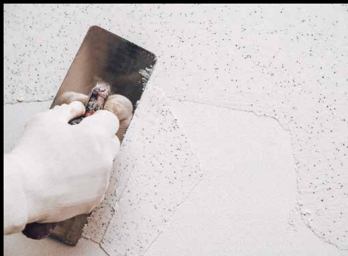
Faza 2 Nanošenje dekorativnog materijala Pegasus čeličnom gletericom
