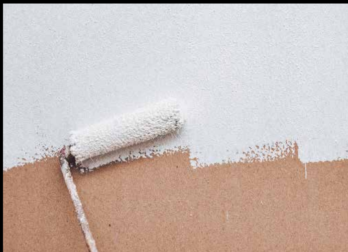
Faza 1 Nanošenje osnovnog premaza Pegasusu prajmer
