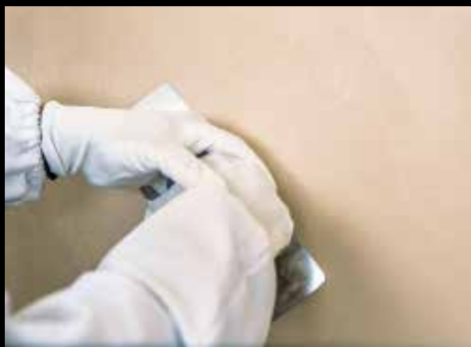
Faza 4 Poliranje gletericom do željenog sjaja
