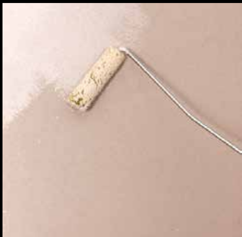
Faza 1 Nanošenje Akрилgrunda
