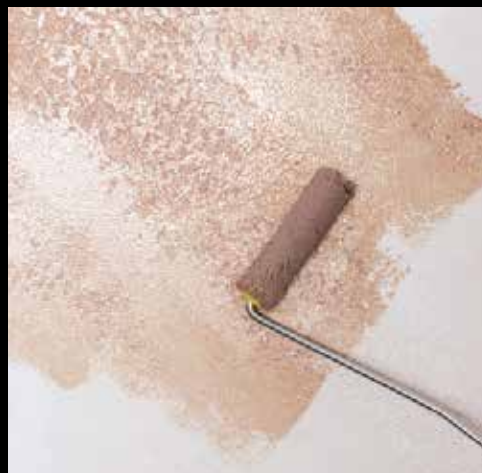
Faza 5 Nanošenje TX Travertino Colora
