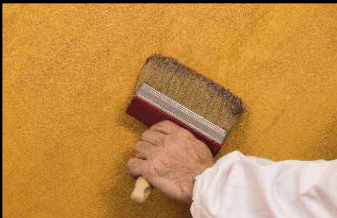
Faza 3 Nakon 5-10min, suvom taper četkom preći preko nanetog dekorativnog materijala
