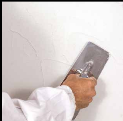
Faza 2 Nanošenje TX Travertina
