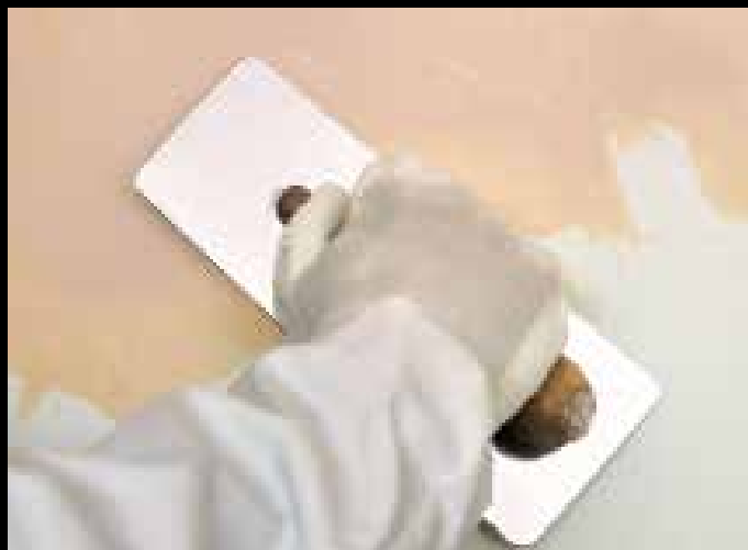
Faza 2 Nanošenje prvog sloja TX Spatulato u željenoj nijansi
