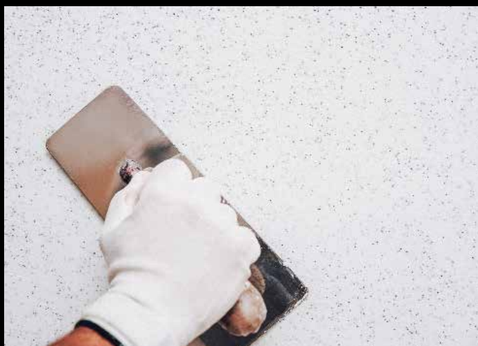
Faza 3 Zaglađivanje i izravnavanje dekorativnog materijala gletericom
